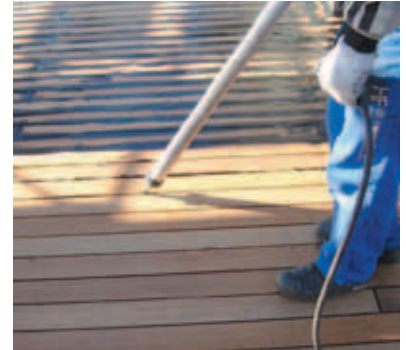
Mit Sikaflex®-290i DC verfugen
