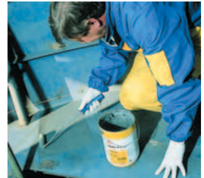
Auftrag von SikaCor® ZP Primer mit einer Walze auf ein Stahldeck
