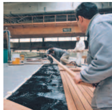
Aufbringen des Decks
