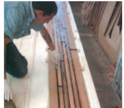
Sikaflex®-290i DC mit einem Spachtel abziehen und einpressen
