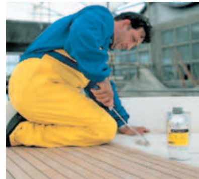
Auftrag von Sika® MultiPrimer Marine mit einer Walze auf eine GFK-Oberfläche
