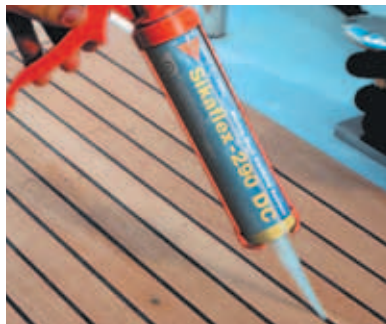
Verfugen mit Sikaflex®
